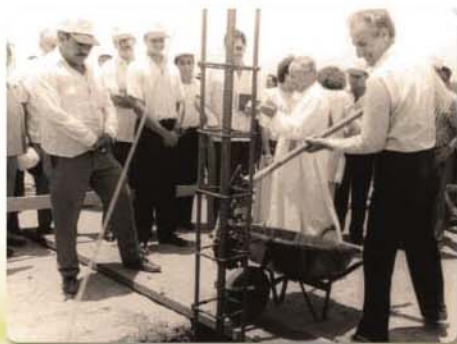
Momentos en que el señor Juan Canahuati coloca la primera piedra de lo que sería el Parque Industrial Zip Choloma.
