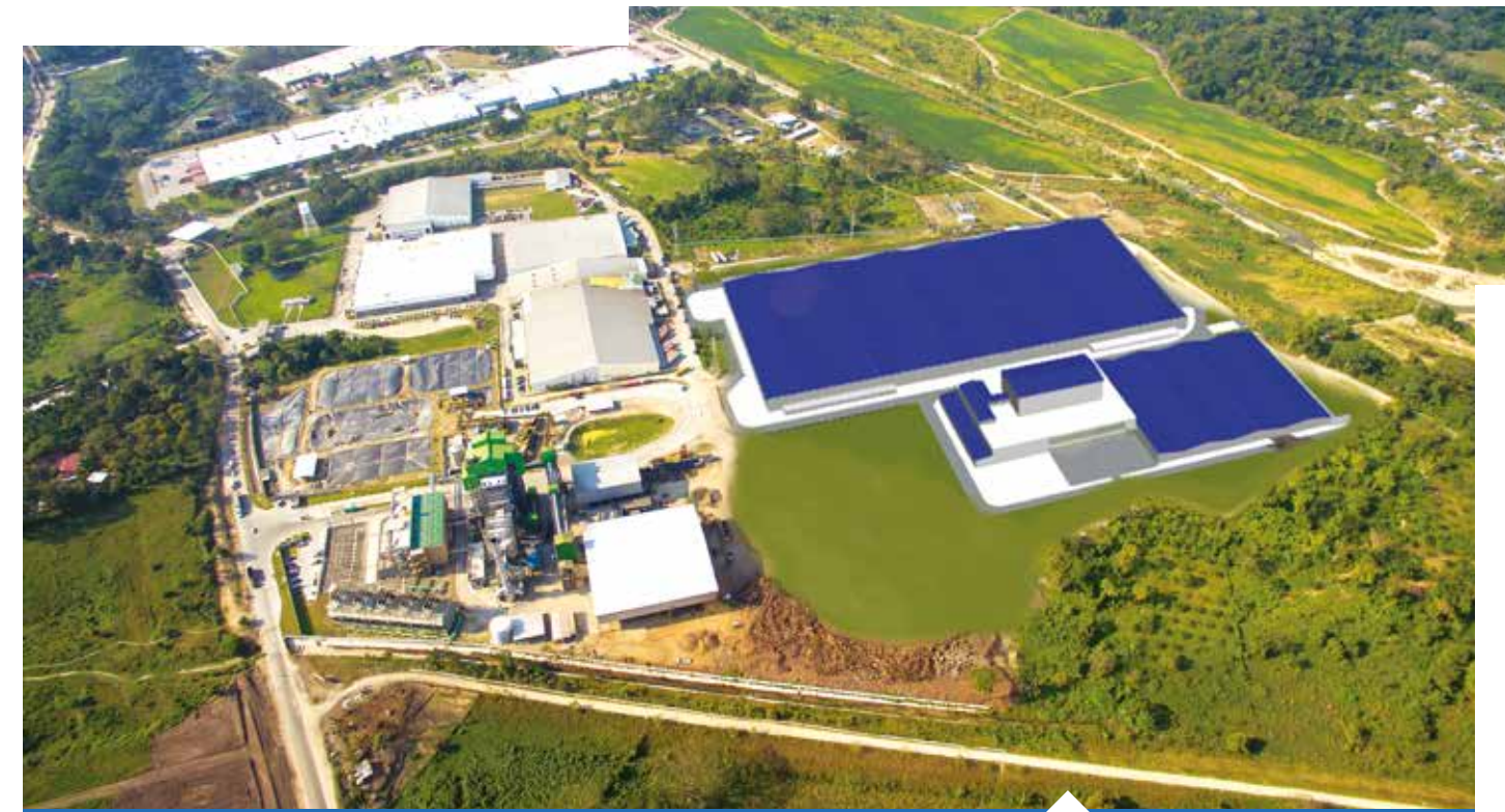
La planta de UNITEXA se construirá en el municipio de Choloma.
