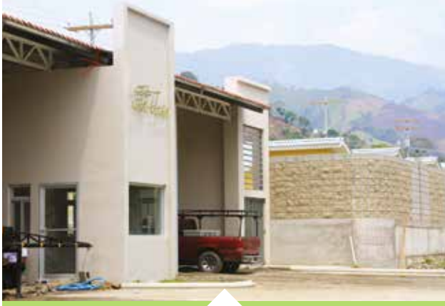
Entrada a la residencial Villas San Juan, ubicada en Choloma.
